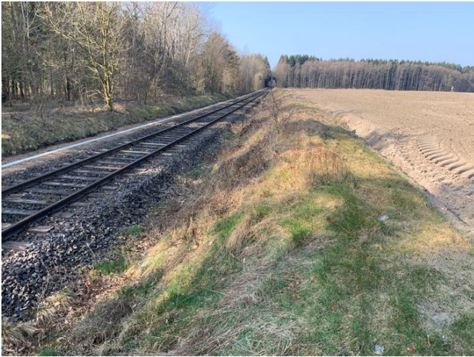
Abb. 5: Bahndamm von Osten
